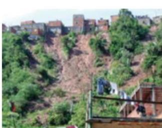
Figura 3.7 – Deslizamentos planares induzidos pela ocupação.
